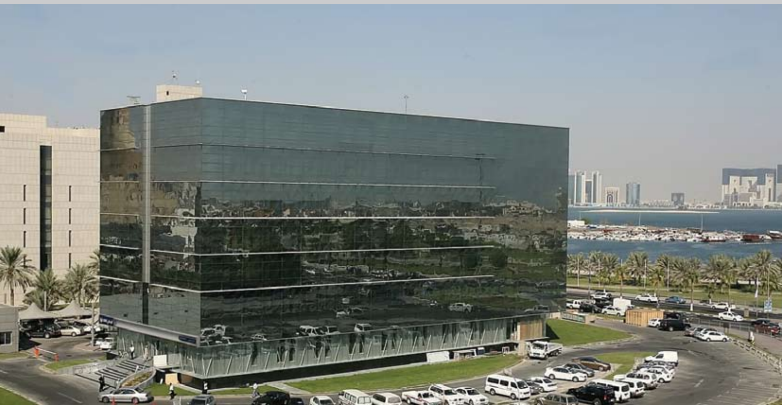
المبنى الرئيسي للبنك
